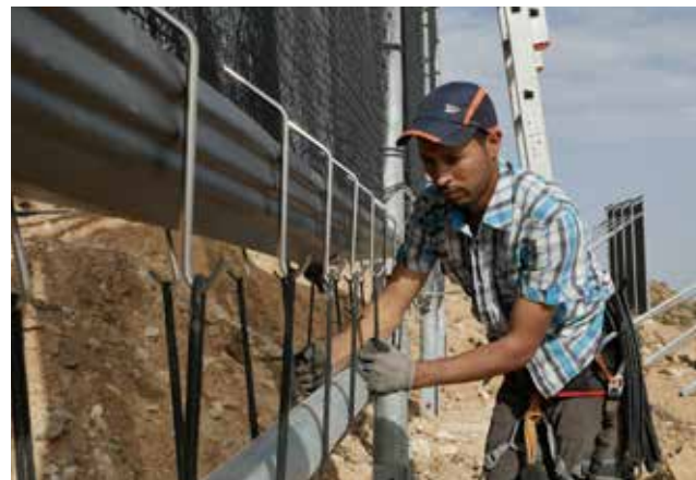
Installation of fog harvesting system. Installation du système de récupération d'eau de brouillard.
