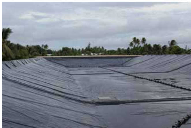
Water reservoir with new liner. Réservoir d'eau doté d'un nouveau revêtement.
