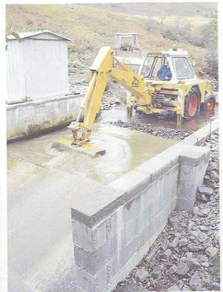
Removal of sediment from above the Crump weir in the Llanbrynmair. Enlèvement des sédiments de la zone surplombant le déversoir de Crump dans le bassin versant de Llanbrynmair.
