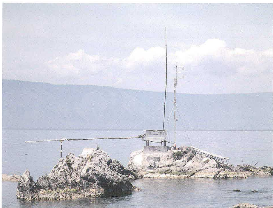
The Hydra installed on Pulo Tao island, Indonesia. Installation de l'Hydra sur l'île de Pulo Tao, Indonésie.
